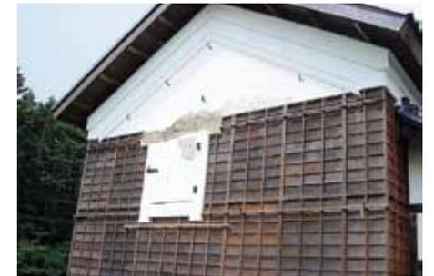
写真1 開拓の村にある剥落した漆喰壁の建造物
