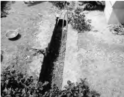
図5-11 土留め石・水路
