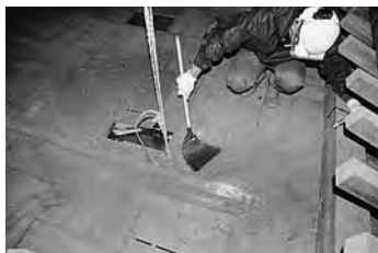
図8-28 天井裏の清掃
