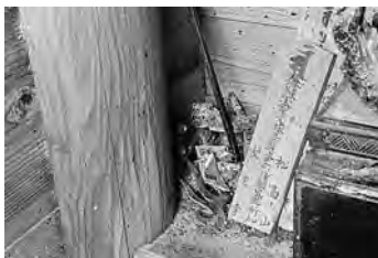
図8-13 仏像から脱落した部材が塵と混在している
