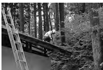
図8-34 管理者らによる土蔵の屋根の清掃
