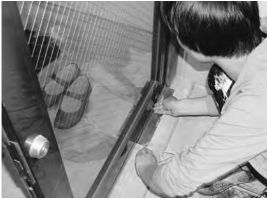
図7-3 ドア下部にシールテープ貼り付け
