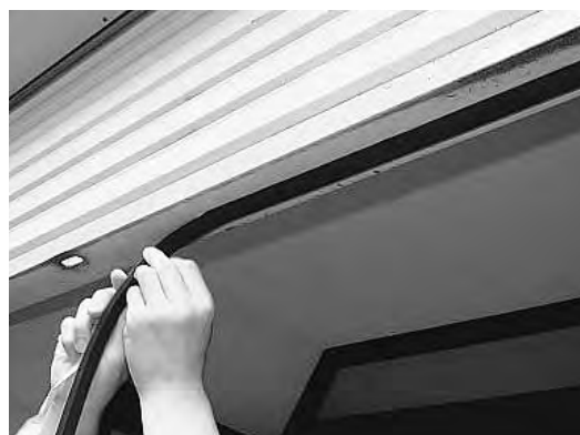
図7-2 シャッター下部への隙間テープ貼付け
