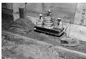
図8-5 木屑が散乱し、仏像の部材が脱落している
