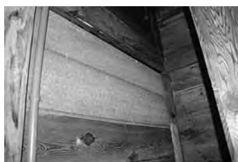
図8-1 高湿度環境によって壁に発生した黴
