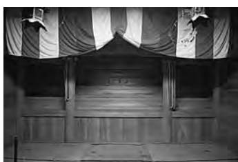
図8-31 清掃後の本堂内部
