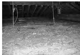
図8-15 本堂天井裏に堆積している小動物の糞や木片や糞などの塵
