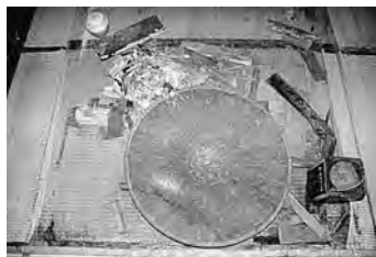
図8-14 小動物の住処となっていた本堂の護摩壇内部
