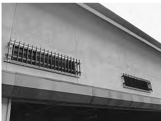
図7-1 防虫網を設置した宝物館窓
