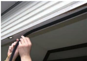
図8. シャッターの下に隙間テープを貼付ける様子
