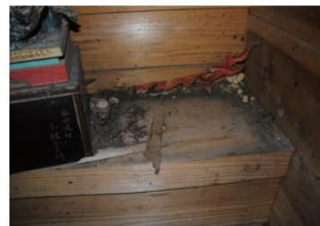
図2. 小動物による被害と考えられる破損や糞など
