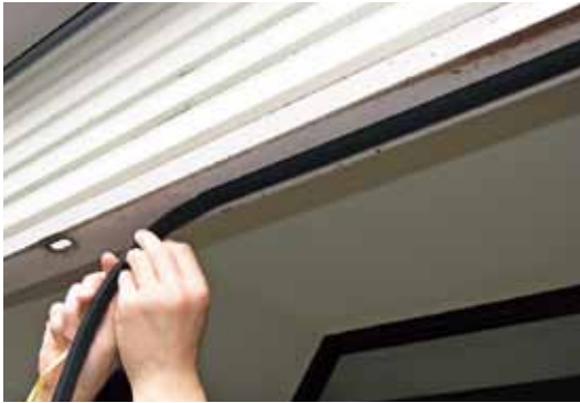
シャッター下への隙間テープ貼付作業
