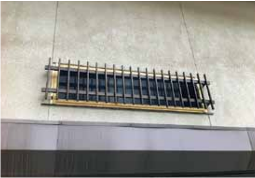
新たに設置した防虫網
