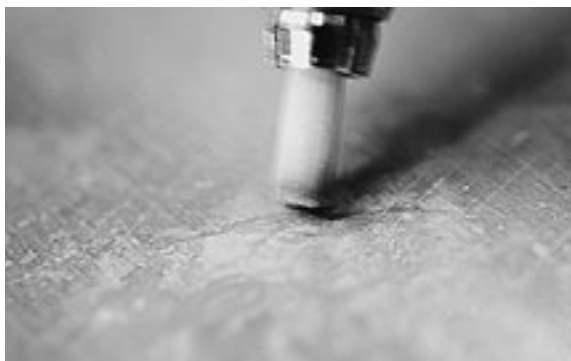
腐食生成物の除去
