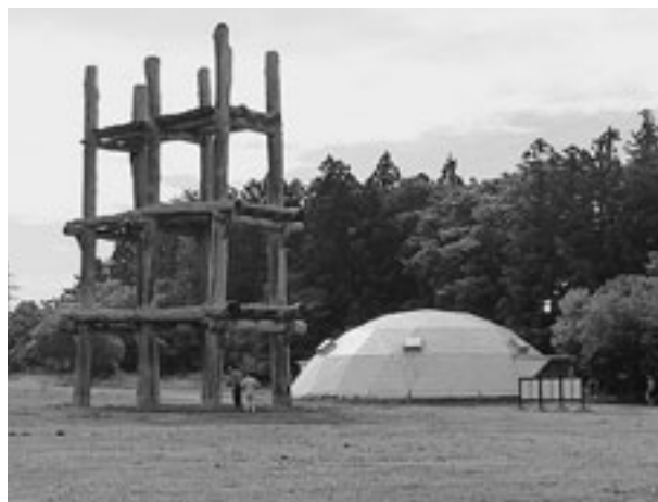
図1-(a) 柱穴を覆うドーム式覆屋（青森県・三内丸山遺跡）
