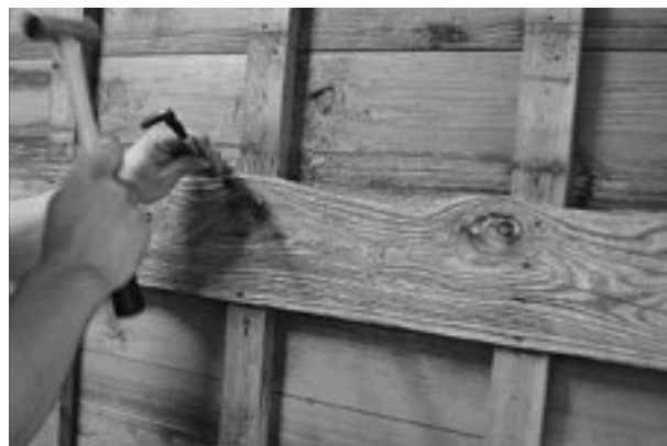
図 8 板材の一部を取り外す
