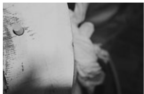
新調したダボの取り付け
