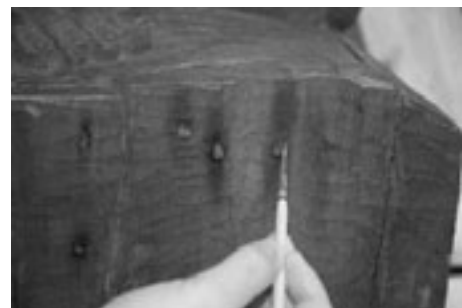
釘の腐食部にタンニン酸防錆剤を塗布。
