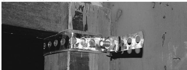
図 1. 建物を傷つけないように配慮した暗幕の取り付け金具
