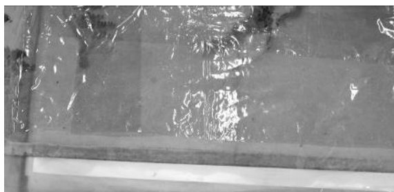
図 7. 緑青部分の洗浄 洗浄前
