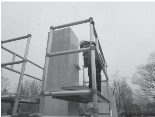
図 15. 側面の防水処置
