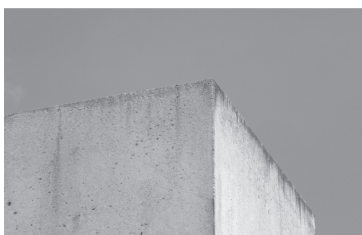
図 9. 側面の汚れ
