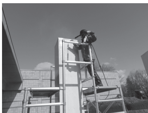
図 13. 高圧洗浄機を用いた表面洗浄
