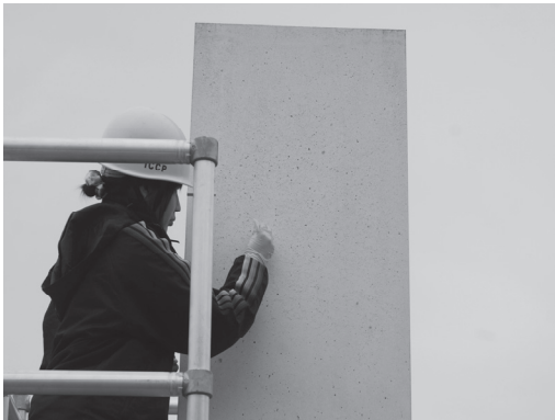
図 14. 上面の防水処置
