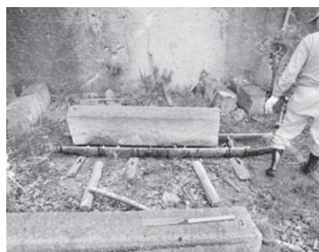
図4-24 石材の運搬（平坦面2）
