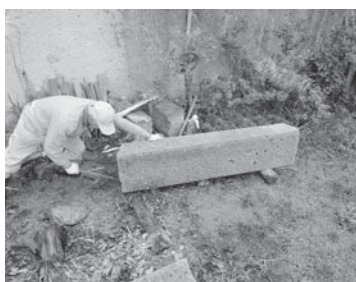
図4-23 石材の運搬（平坦面1）
