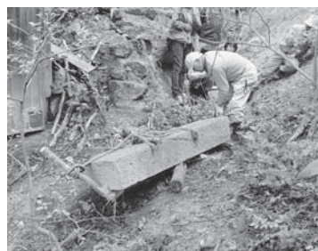
図4-25 石材の運搬（急斜面）
