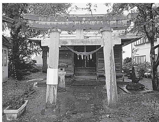
図4-34 柱が修理された鳥居
