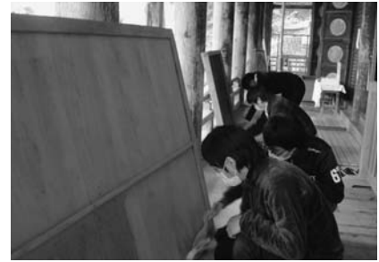
図4-59 刷毛による裏面の清掃
