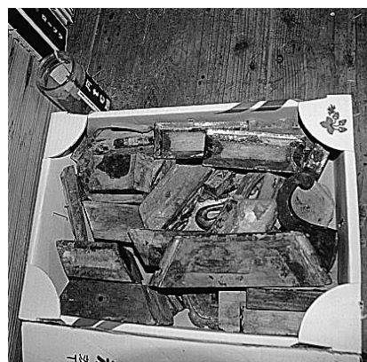
図2-24 薬師堂 図2-22の観音菩薩像の台座の崩壊した部材などが段ボール箱に詰められて保管されている
