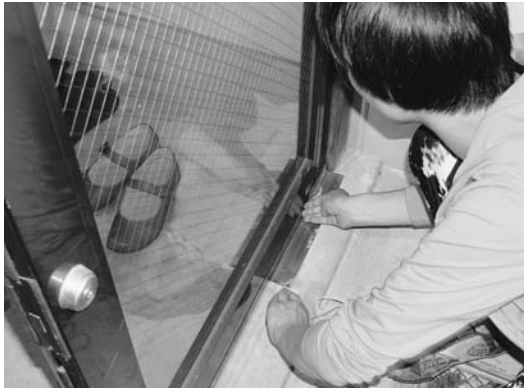
図7-3 ドア下部にシールテープ貼り付け
