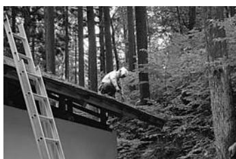
図8-34 管理者らによる土蔵の屋根の清掃
