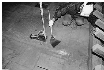
図8-28 天井裏の清掃
