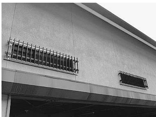
図7-1 防虫網を設置した宝物館窓
