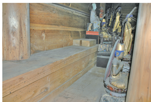
写真24 清掃後の状態
