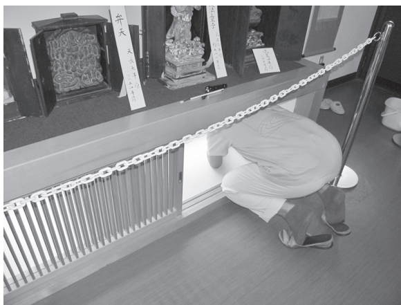
写真11 西側展示台の下窓の調査の様子
