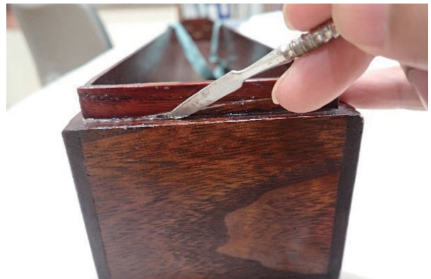
図78. 人工木材充填
