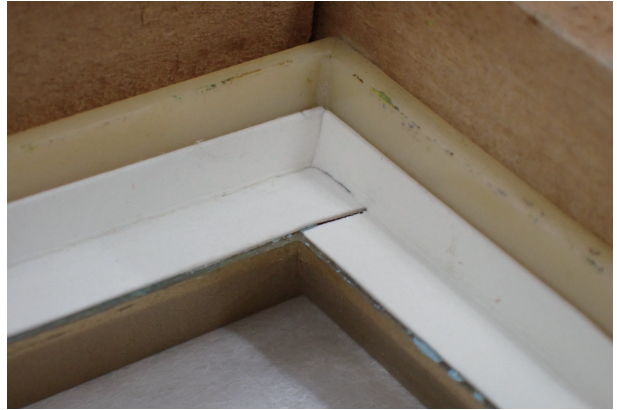
図48. 入子をピュアガードで補強
