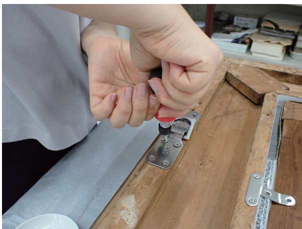
図41. 新規の吊り金具を取り付け
