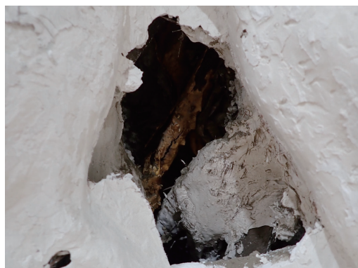
図2 切断して取り外した状態
