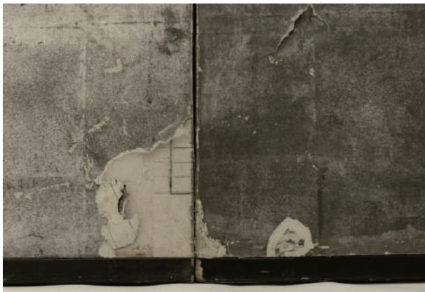
図35. 裏張り紙の破れ_修理前
