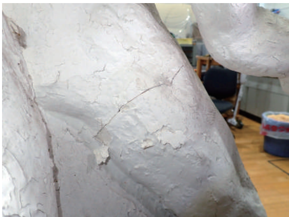
▲図5 正面男性像大腿部の亀裂
