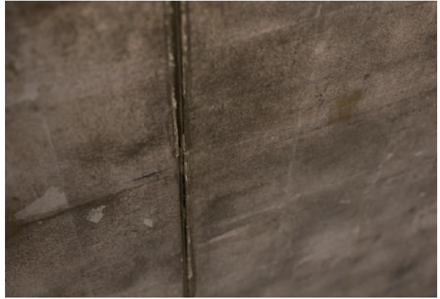
図38. 裏張り紙の破れ_修理後
