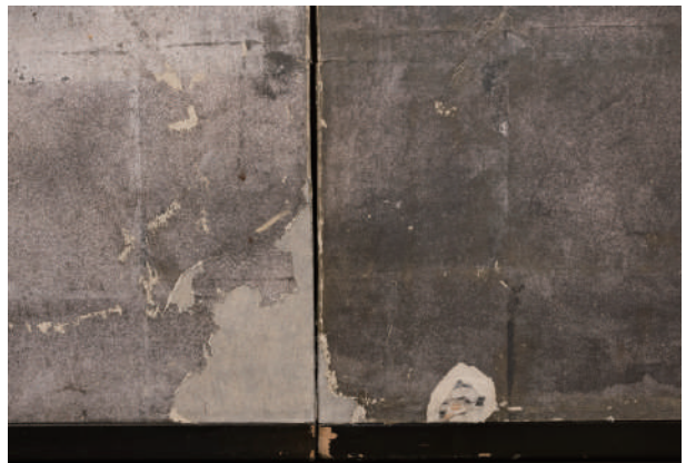
図36. 裏張り紙の破れ_修理後
