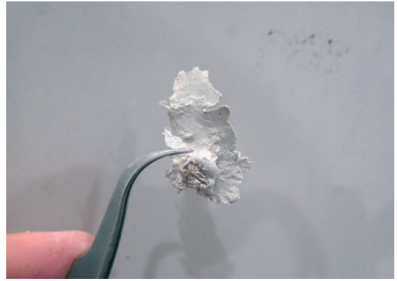
▲図11 除去した充填材
