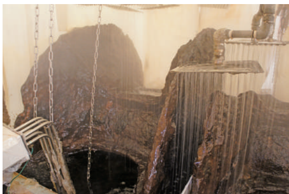
図6 シャワーによる含浸処理
