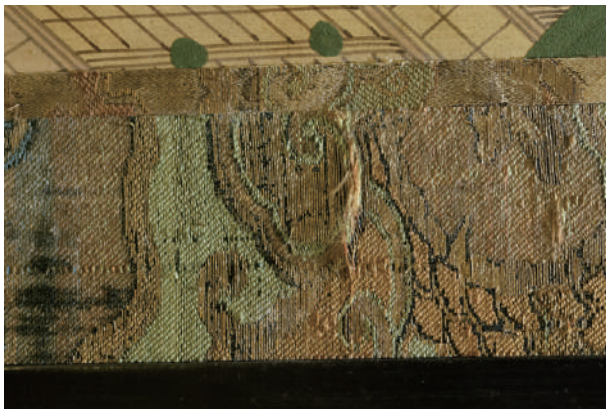
図23. 大縁の解れ_修理前
