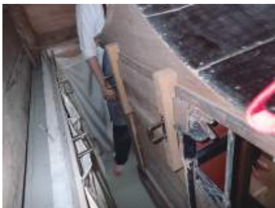
▲建物と厨子に金具を設置
