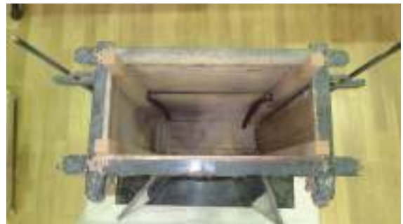
▲胴部四隅に柱を新たに設置
