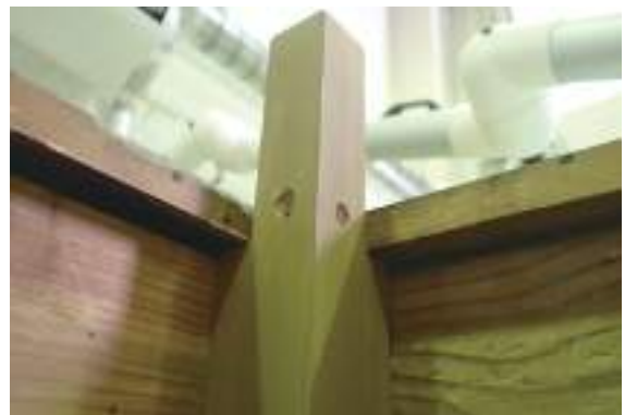
▲柱の高さを屋根内部まで伸ばした
