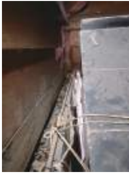
▲建物と屋根を紐で固定
