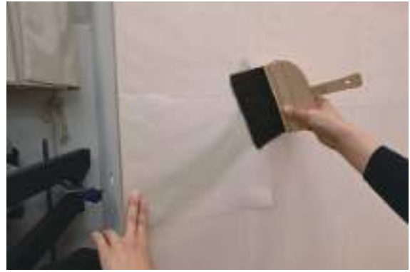
図75. 下貼り_⑥下浮け
