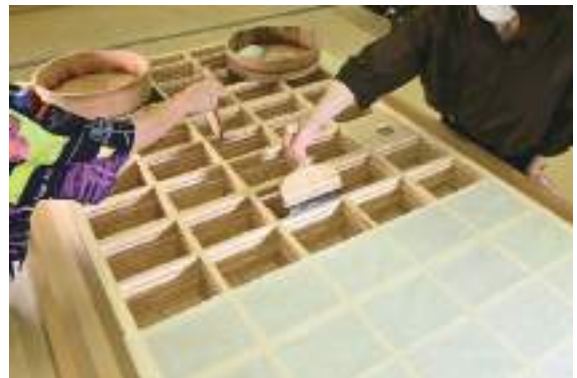
図71. 下貼り_②骨縛り
