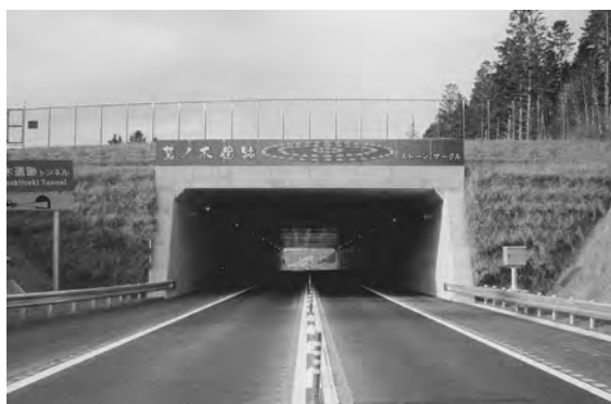
図1. 鷲ノ木遺跡およびボックスカルバートの状況
