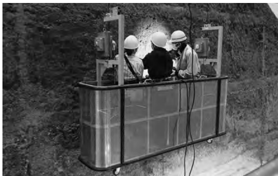
写真4. ゴンドラからの堤体表面調査
