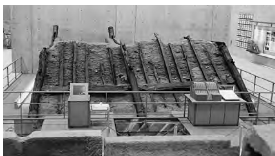
写真2. 木製枠工
