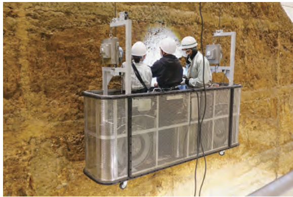
写真 4. ゴンドラからの堤体表面調査
