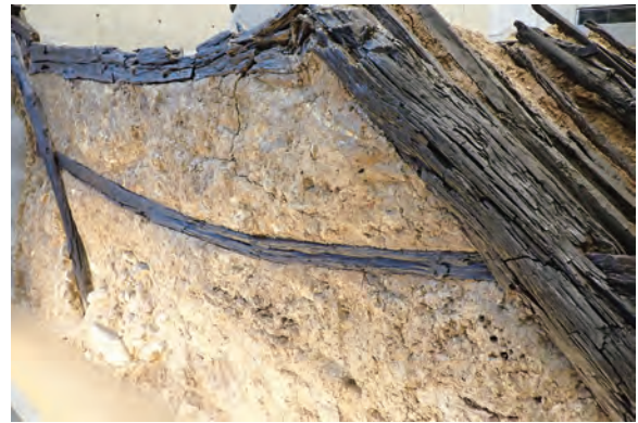
写真 5. 木製枠工の現状
