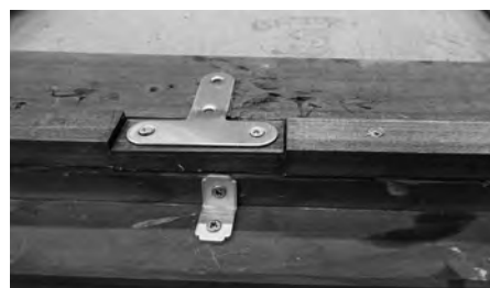
図16. 処置後：整形したT字金具を設置する箇所のみ、工程17の材は高さ調整のため、少々高さを低く加工している
