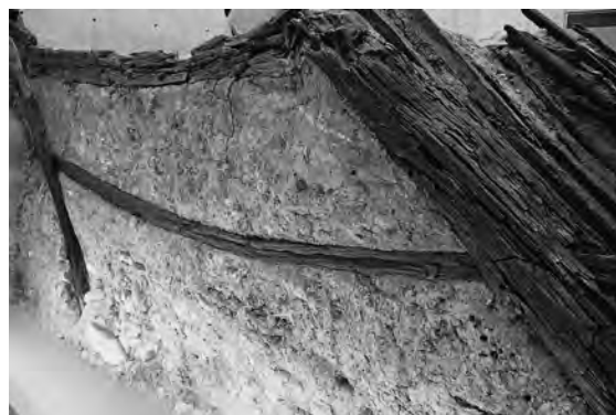
写真5. 木製枠工の現状
