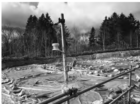
図5. 外気の温湿度測定装置およびタイムラプスカメラの設置状況
