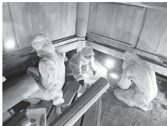
▲防護服を着用し、床下で調査を行った
