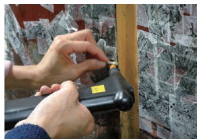
図17. 加湿・加温して養生紙を除去
