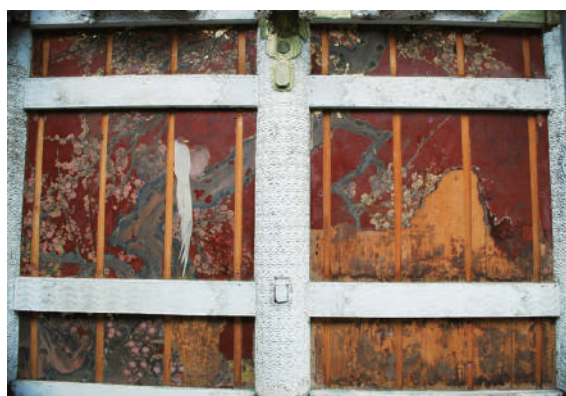
図1. 東側壁面全体図（修理前）
