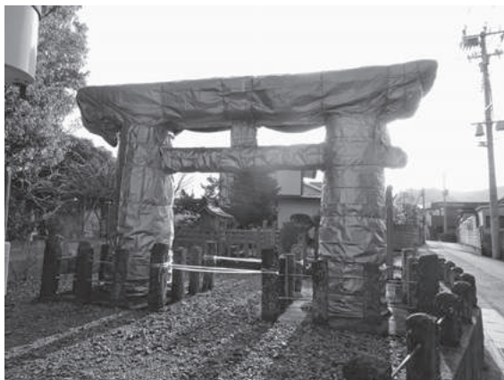
写真1. 石鳥居の冬季養生の様子
