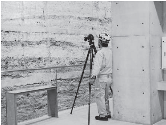
写真4. 機器による堤体表面調査
