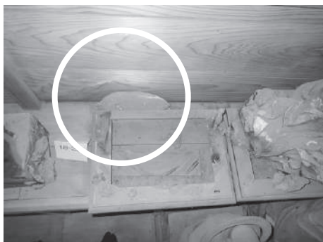
▲【18-29】の台座裏側に部材が落下
