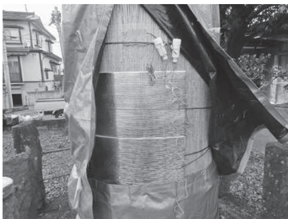
写真2. 養生内部に断熱材の設置状況
