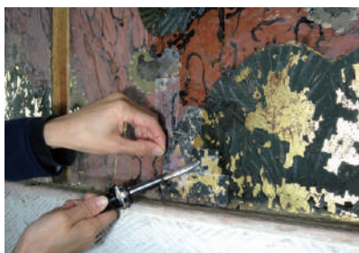
図16. 緩衝材の上から電気ゴテをあてる
