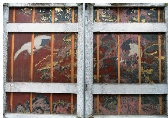
図2. 西側壁面全体図（修理前）
