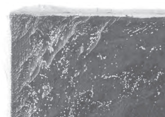
図4 画面左上の剥落箇所修復前
