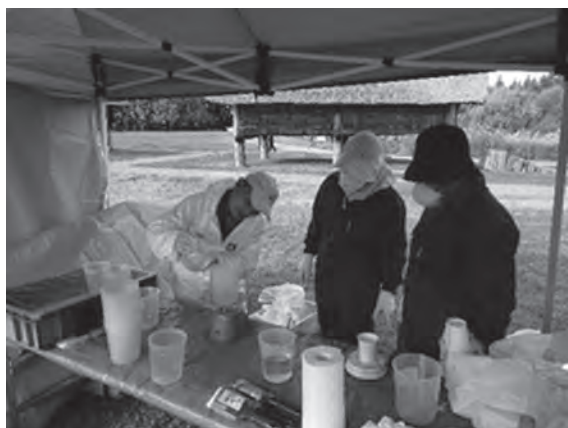
図5. エポキシ樹脂主剤と硬化剤を計量して混合する
