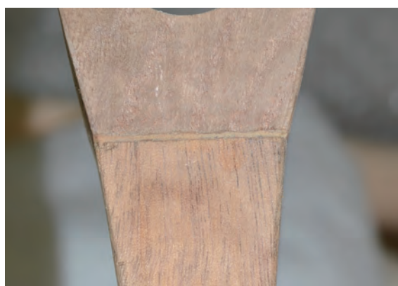
写真8 欠損部の接合後
