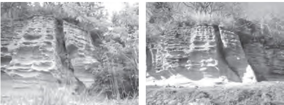
写真－2 大切岸（左：施工前、右：施工後）
