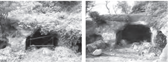
写真－3 やぐらの例（左：施工前、右：施工後）
