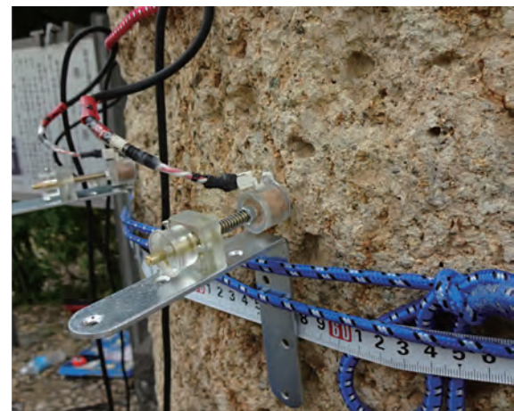
図16. 音波センサー設置部分の拡大写真
