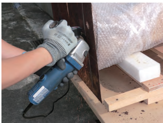
写真3 固定台座の解体
