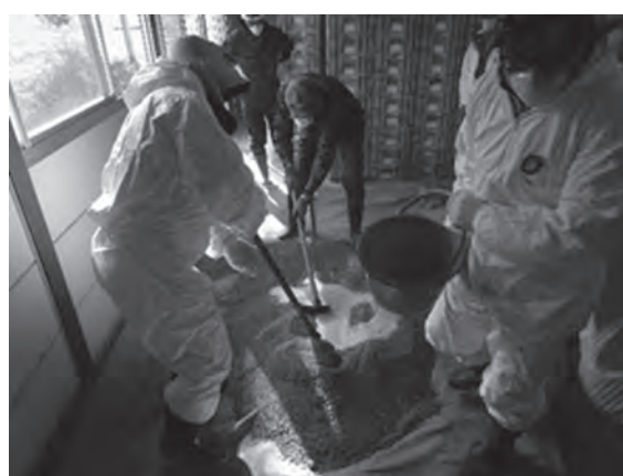
図8. 遺跡周辺の土と珪砂8号を混合している様子
