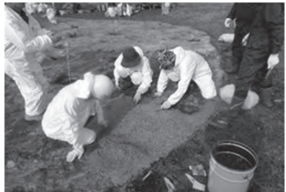
図13. 擬土をFRP表面に塗布している状況
