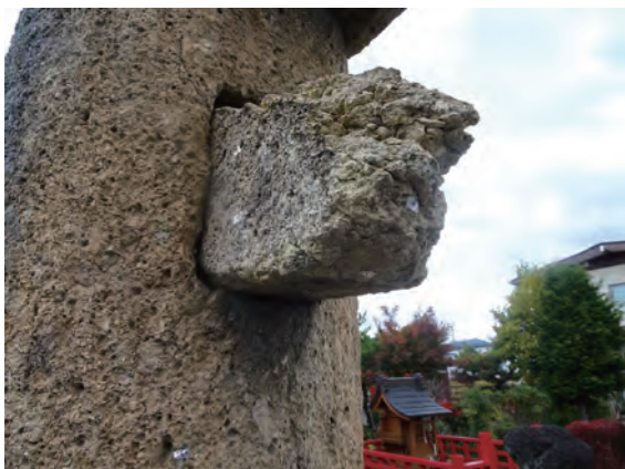
図6. 測定点H（貫部分）の石材表面状況
