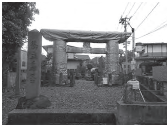
写真1. 石鳥居の冬季養生の様子
