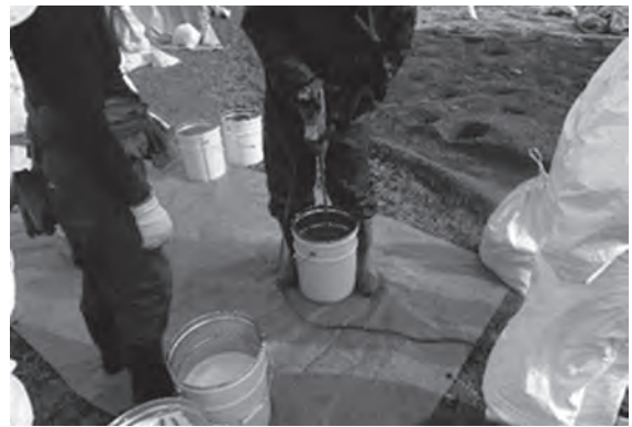
図12. エマルジョンと土をミキサーで混合している状況
