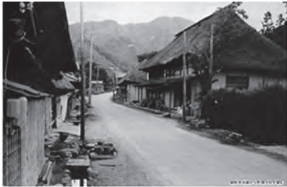
図6 新町の町並み（宿尻から）
