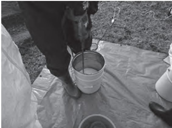
図10. 水を入れミキサーで混合しエマルジョンを作成
