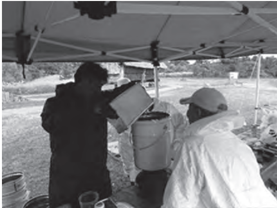
図9. サイトFX主剤と硬化剤を混合している状況
