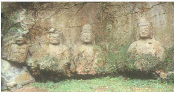
図4. 塩類風化による激しい劣化（白杵石仏）
