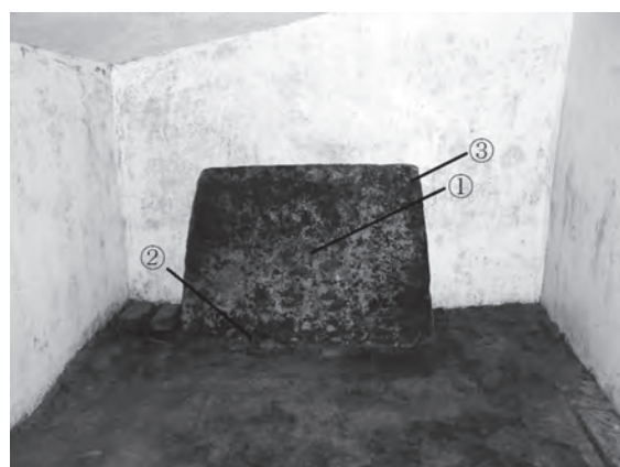
図2：扉石と試料採取箇所：①正面中央中部、②正面中央下部、③右側面上部
