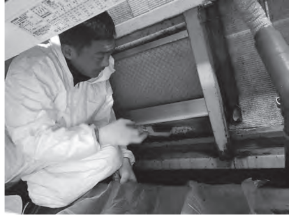
写真13. 覆屋基底部の鉄骨の錆落としをしている様子
