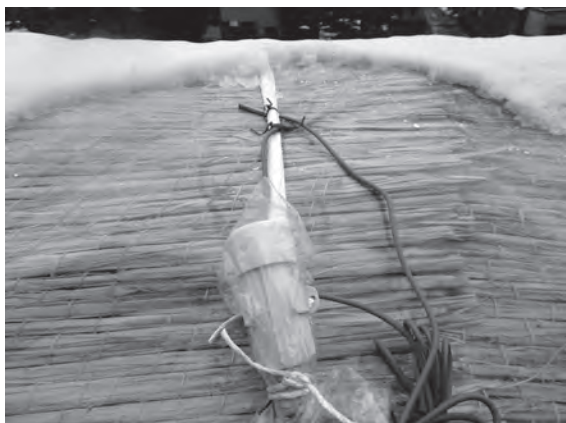
写真2、笠木養生内部と鳥木石材表面の温度センサー設置状況
