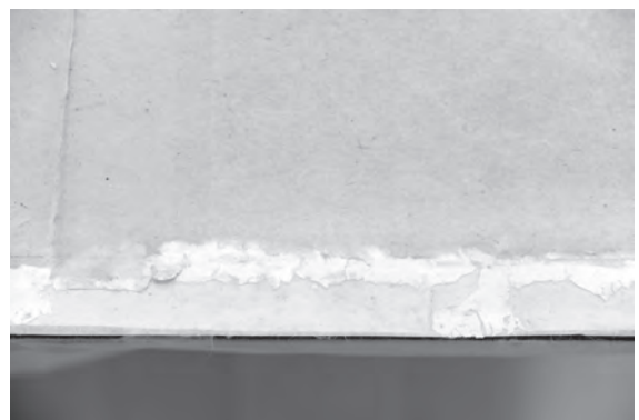
図5 張りしろの強化処置
