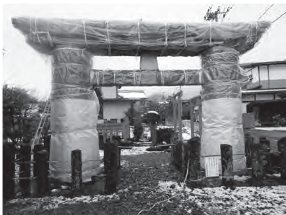
写真1、石鳥居の冬季養生の様子
