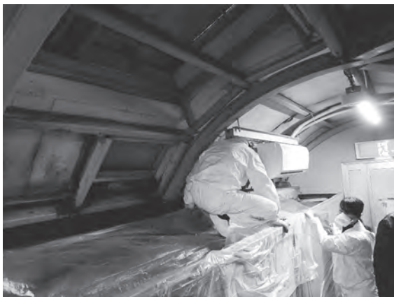
写真12. 遺構面上部に、養生シートを設置している様子
