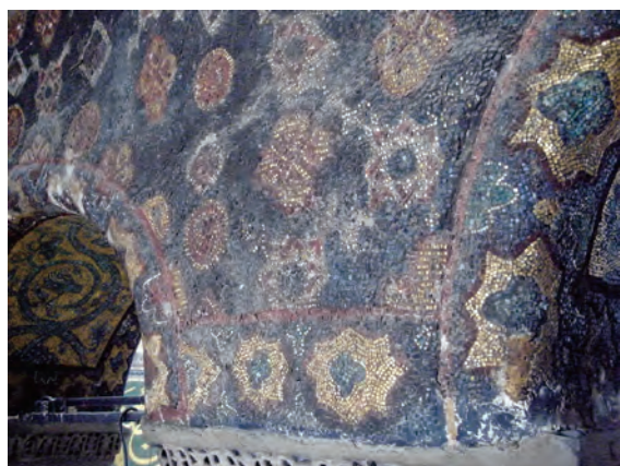
図13. 列柱西6上部壁および西6-7間アーチ 接続部の窪み
