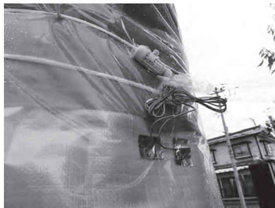
写真4、北柱部分の養生内部の石材表面と養生表面の温度センサー設置状況
