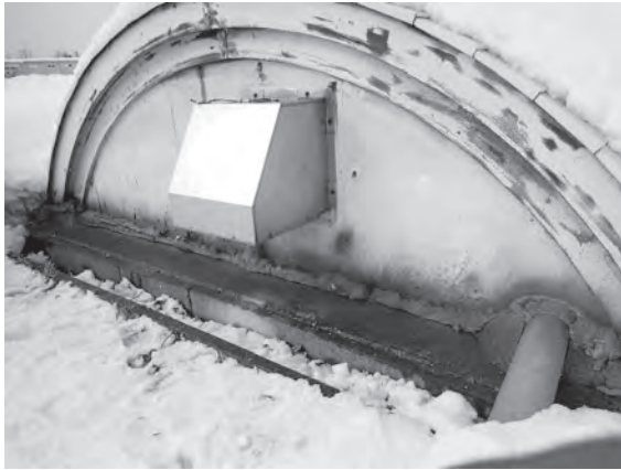
写真16. 覆屋基底部の壁面欠損部の修復後の状況
