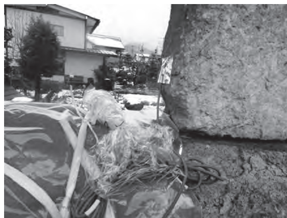
写真3、貫養生内部と額束石材表面の温度センサー設置状況
