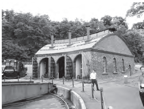
写真2. 重要文化財旧手宮鉄道施設の様子
