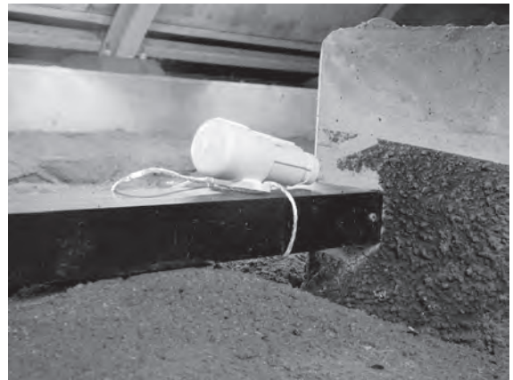
写真8. 南盛土内の温湿度変化を測定するための温湿度データロガー設置状況
