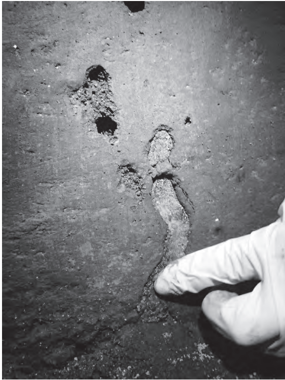
写真11. 擬土を用いて欠損部分を補修している様子
