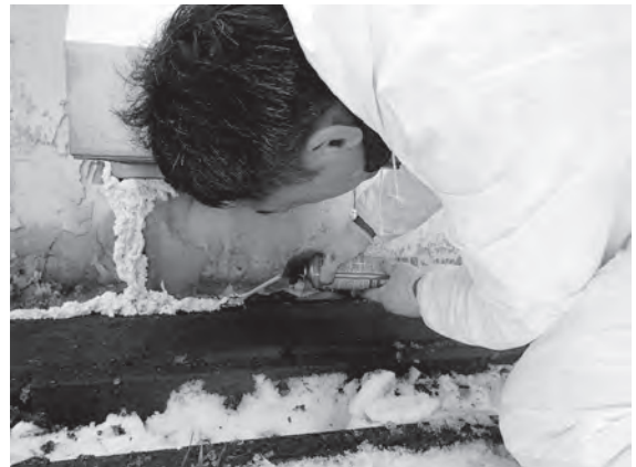
写真15. 覆屋基底部の壁面欠損部に硬質ウレタンを吹き付けている様子
