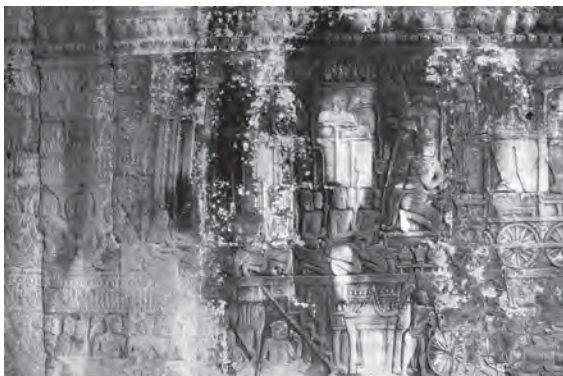
写真3：浅浮彫り表面に発生したバイオフィーム
