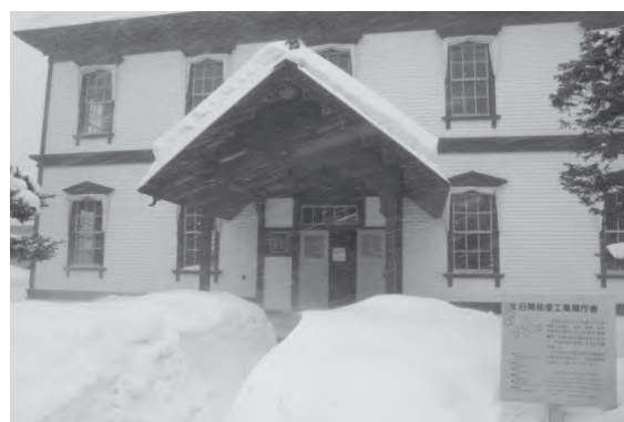
写真2 積雪下の工業局庁舎（2012年2月）
