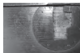
図6. 漆塗膜の劣化
