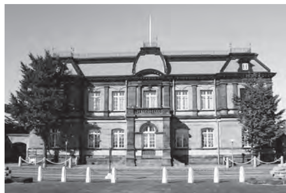
写真1：旧日本郵船株式会社小樽支店外観
