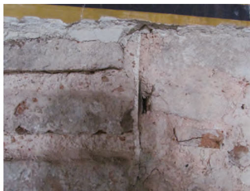
図13. 窓の修復以前の壁材が残存している箇所
