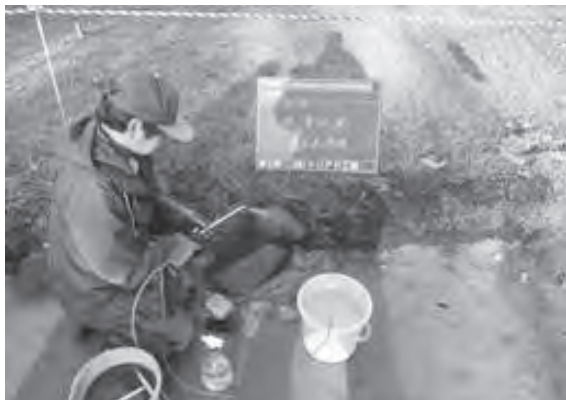
図4 小牧野遺跡 高圧洗浄状況
