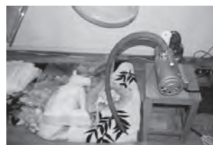
図15. 低圧樹脂含侵の作業中
