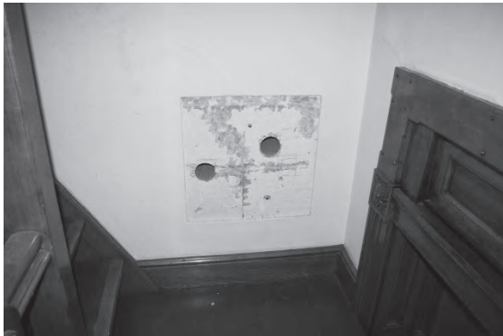
写真7：屋内小階段室の躯体石材コア抜き
