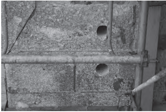
写真6：躯体石材のコア抜き
