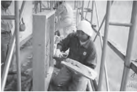
図8. 試験土壁の作成状況
