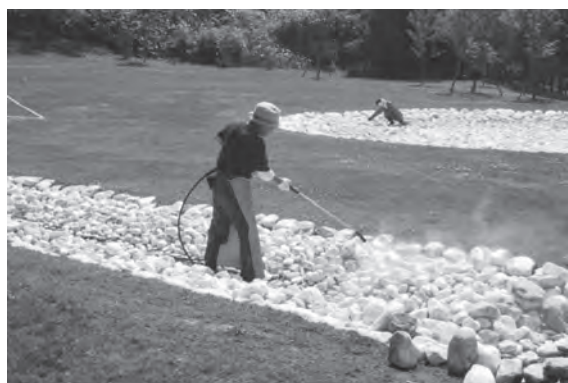
写真5：夏期の流路の藻類付着対策の高圧洗浄
