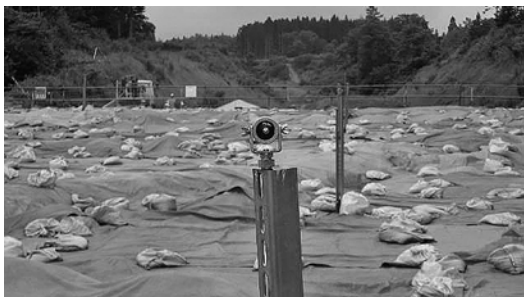
図5 環状列石内に設置したミラーターゲット
