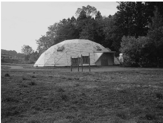
図8 大型掘立柱建物跡覆い屋
