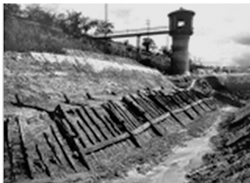
図9-(a) 杵工による補修を施した堤体
