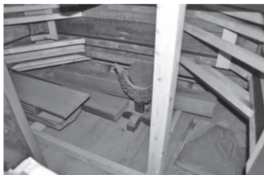
写真 17 須弥壇裏の保管場所
