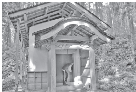
写真2 塩田行屋土蔵（大師堂）
